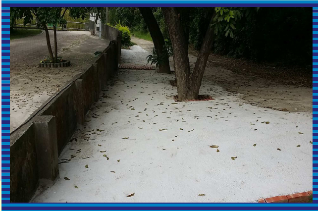
(改善後門圍牆水溝的積水)
