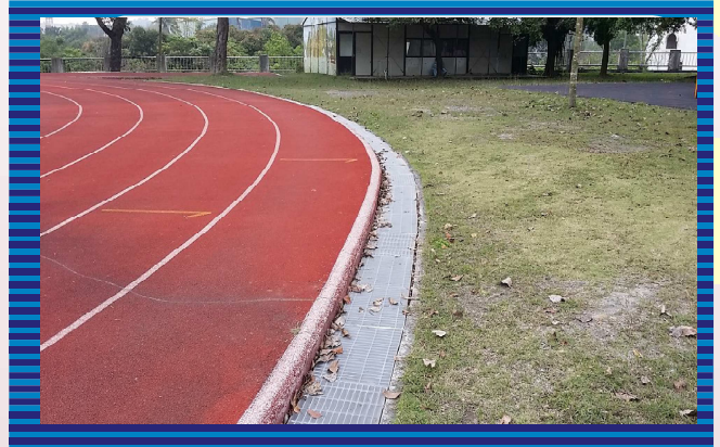
(PU操場四週水溝鋪設紗網)
